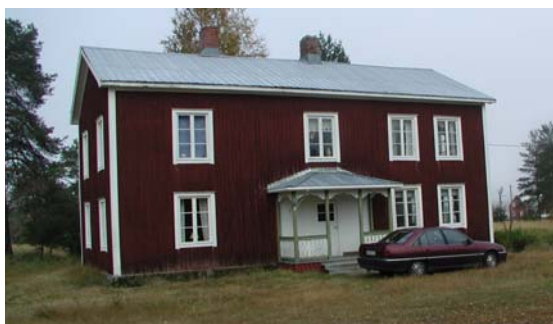
Mangårdsbyggnad Västra Lainejaur 1:44
