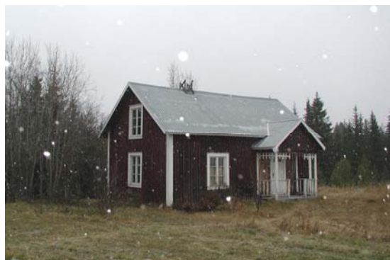
Norra sidan om vägen
