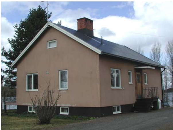
Gäddan 1 Villa från 1955 med bevarad bro med smäckert skärmtak och balkongräcke. Tidstypiskt är också inramningen av tegel runt entrédörren och fönsterutformningen.
